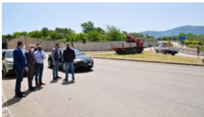
Controllo sui lavori in corso a poca distanza dall'abitato di Guardia Sanframondi
