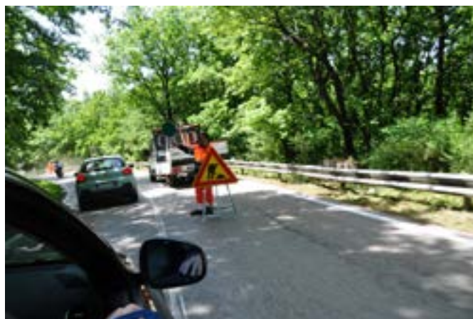
Lavori in corso a Telese Terme
