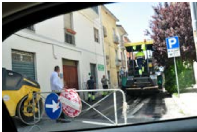
Lavori in corso a Castelvenere
