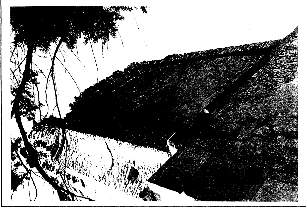
FOTO N.2 - TORRE COLOMBAIA: PROSPETTO LATERALE
