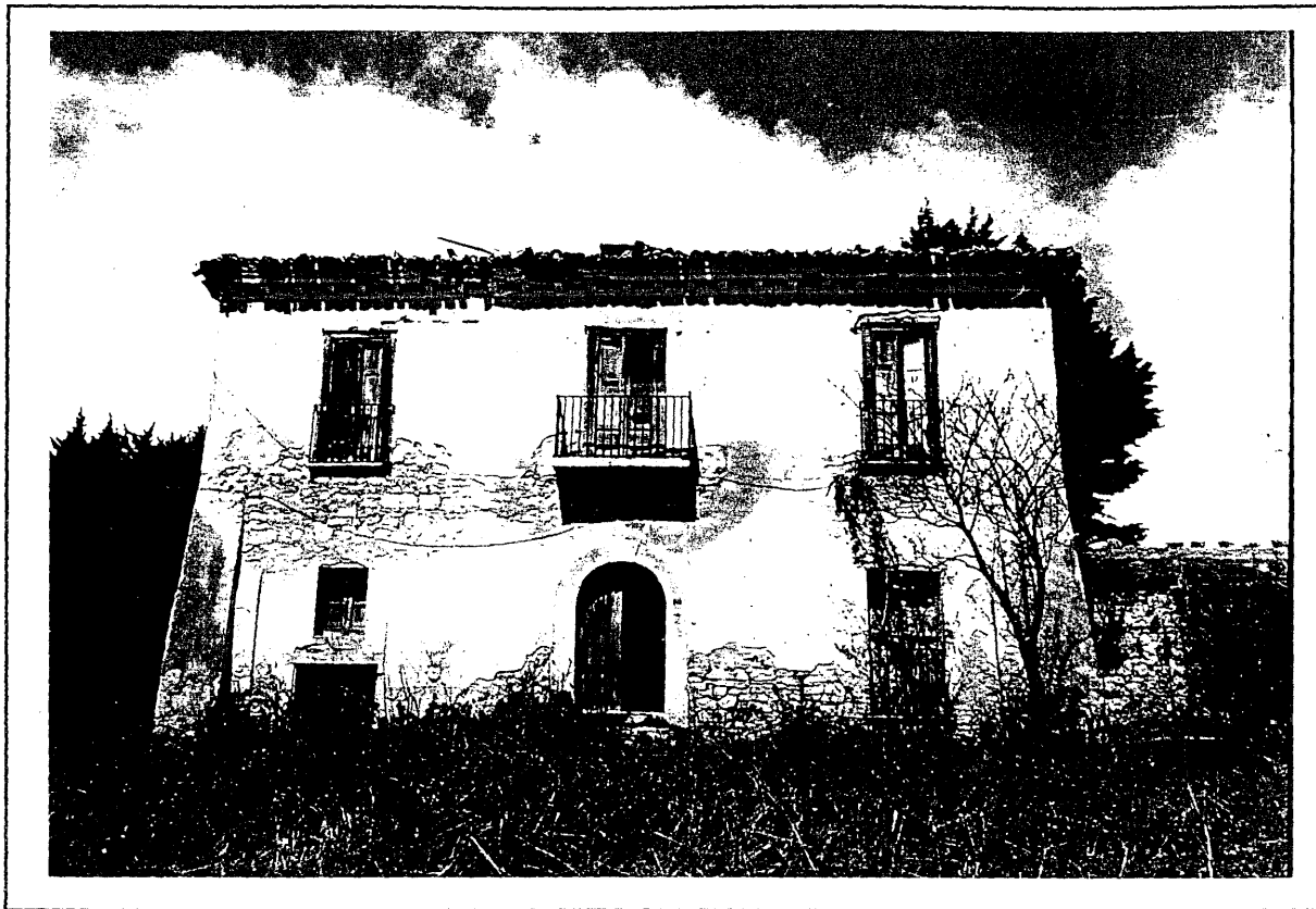
FOTO N.1 - CASCINA PANARI: PROSPETTO ANTERIORE
