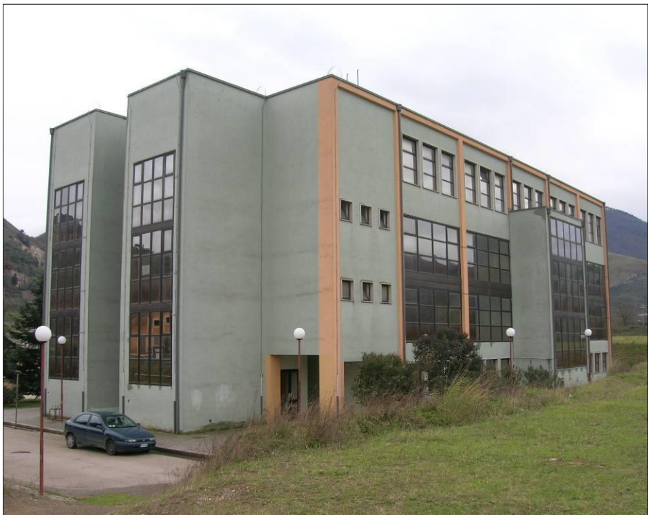
la facciata posteriore e laterale fronte nord e nord est
