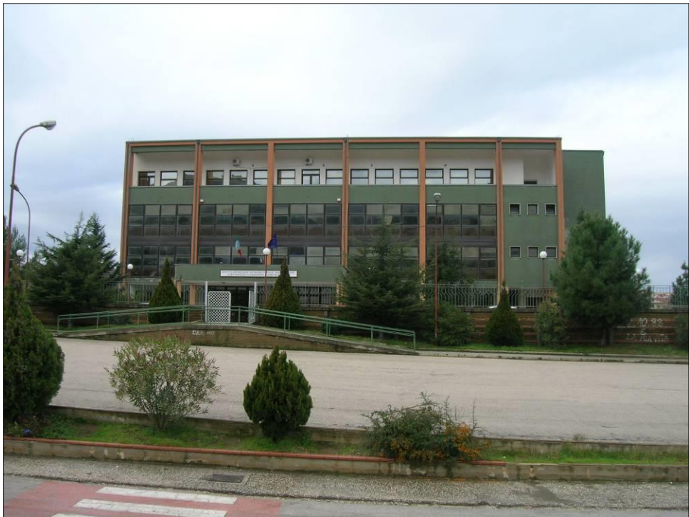
la facciata dell'ingresso edificio esistente, fronte sud
