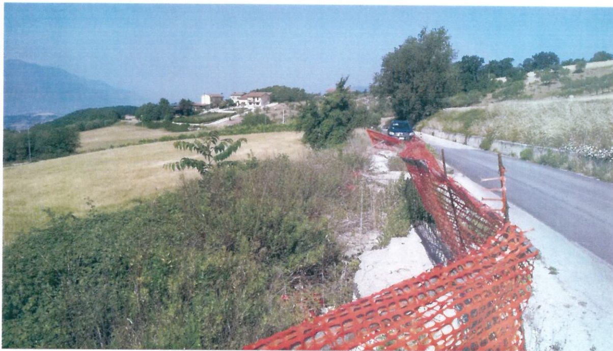
Foto 1 - fronte del movimento di massa che ha coinvolto parte della carreggiata della S.P. 95
