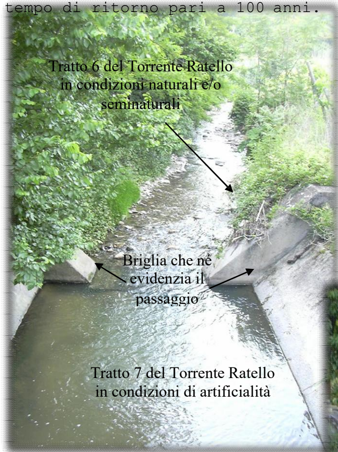
Fig. 154 - Tratto 7 Torrente Ratello. Nella foto è evidenziato il passaggio dalle condizioni di naturalità e/o seminaturalità a quelle di completa artificialità del Torrente Ratello. La Briglia qui presente delimita tale limite.
