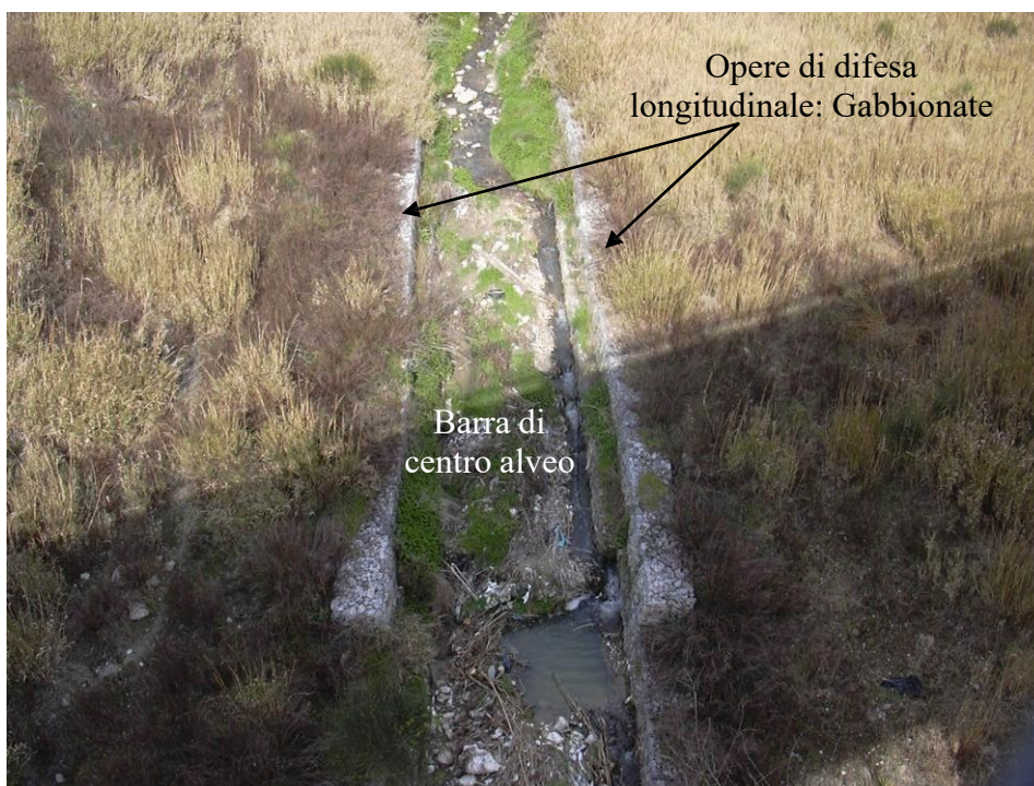
Fig.141 - Tratto 2 Torrente Ratello: vista delle opere di difesa longitudinale dal ponte su cui scorre l'arteria stradale "La Bretella"; e della barra di centro alveo che determina una variazione della sezione dell'alveo.
