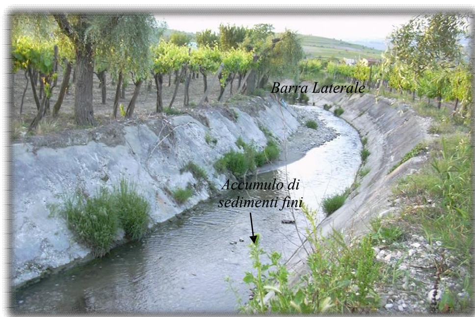
Fig. 160 – Tratto 8 Torrente Ratello. Nella foto si osserva una porzione del tratto analizzato prossimo alla confluenza dove è stato possibile osservare accumuli di sedimenti sui bordi e formazione di una barra
