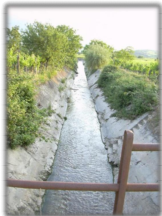
Fig. 158 – Tratto 8 Torrente Ratello. Nella foto si osserva l'andamento rettilineo dell'alveo
