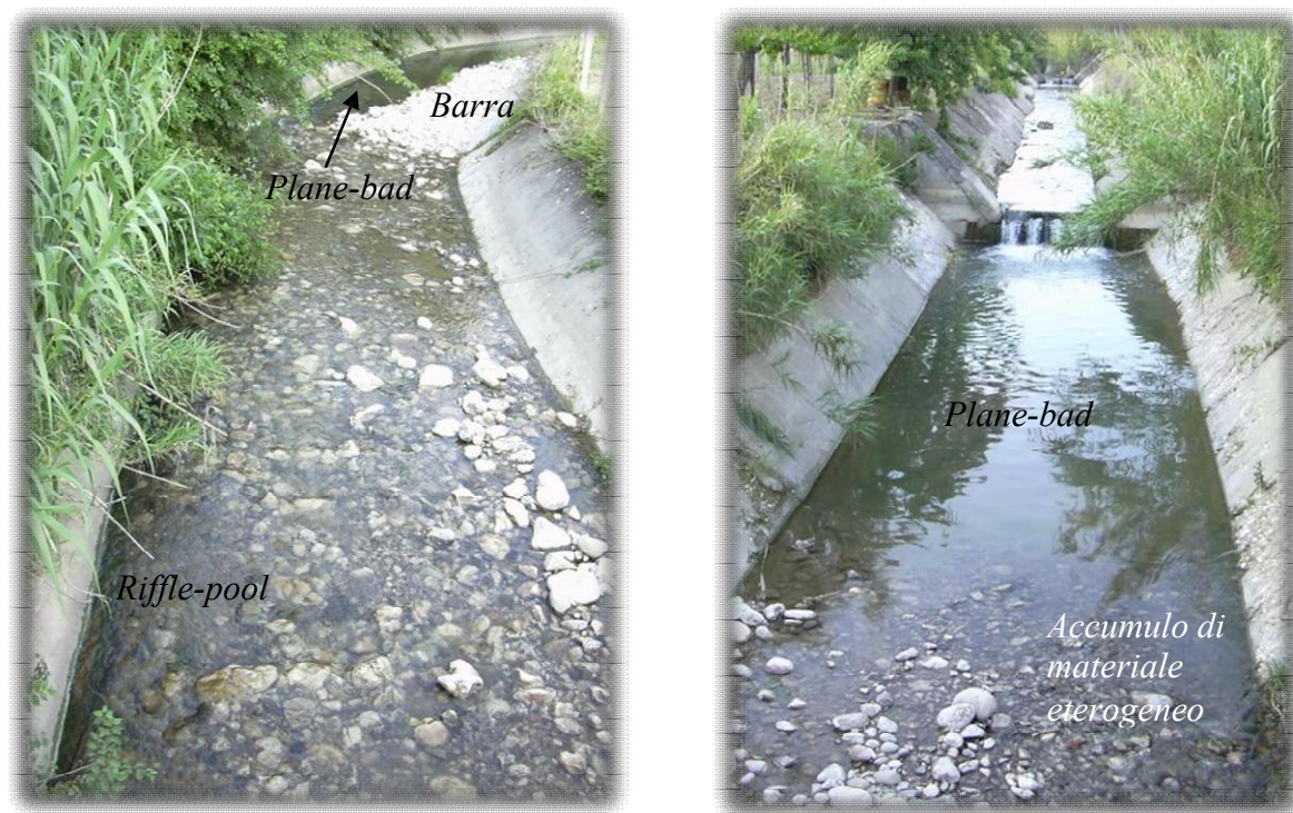
Fig.156 - Tratto 7 Torrente Ratello. Nella foto vista delle morfologia di fondo riscontrata nel tratto in esame in prossimità dei due ponti che lo attraversano. (a) ponte a monte del tratto in cui è visibile la morfologia a plane-bed con evidenze di riffle-pool e della barra laterale; (b) ponte a valle del tratto in cui è possibile notare nuovamente la condizione di Plane-bed e l'accumulo di materiale eterogeneo.
