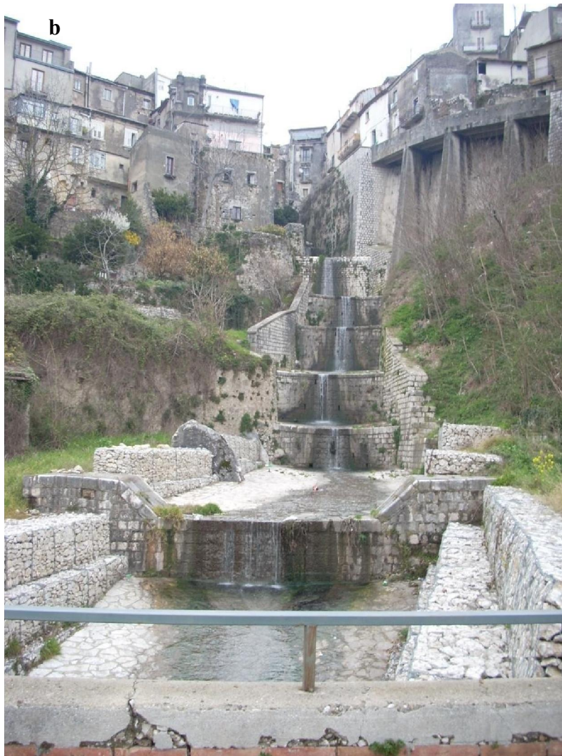
Fig.139 - Torrente Ratello: (a) Tabella riepilogativa per il calcolo dell' IQM; (b) Vista del tratto 1 studiato; nella foto è rappresentata l'opera di Ingegneria Naturalistica del progetto "Opere di difesa spondale e arginale del Torrente Ratello" realizzata nel 2006 .
