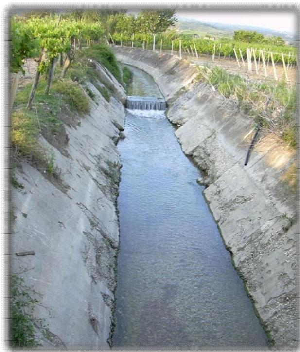
Fig. 159 – Tratto 8 Torrente Ratello. Nella foto si osserva la presenza di una briglia di consolidamento che causa una variazione del profilo longitudinale.
