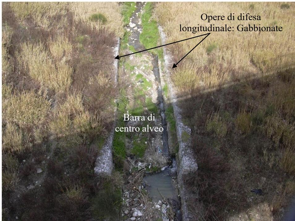
Fig.141 - Tratto 2 Torrente Ratello: vista delle opere di difesa longitudinale dal ponte su cui scorre l'arteria stradale "La Bretella"; e della barra di centro alveo che determina una variazione della sezione dell'alveo.
