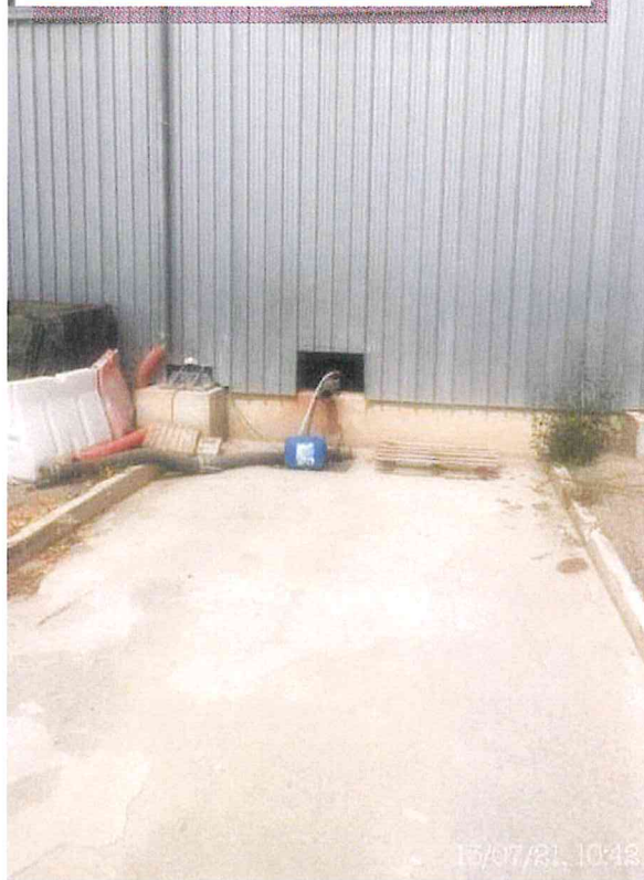
Vista piazzola e presa di carico percolato
